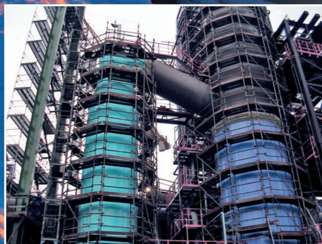
Ob moderne Anlage zur Stromerzeugung aus Biomasse oder Modernisierung bestehender Industrieanlagen: Optimierte Funktionalität – farbliche Tristesse adé!
